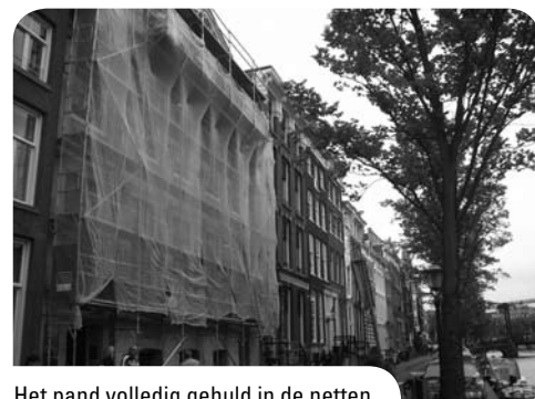
Het pand volledig gehuld in de netten
