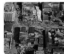
Overal ingestorte gebouwen in Haïti
